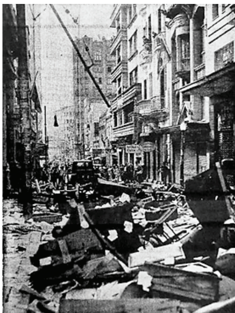
Imagem 30 – Rastro de destruição pela Rua da Praia em Porto Alegre (24/08/1954)
